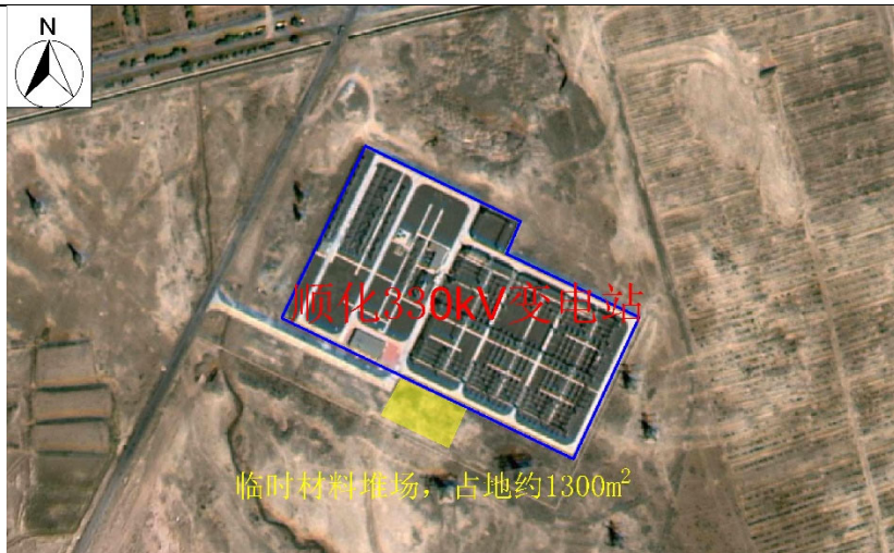
顺化 330kV 变电站临时材料堆场
